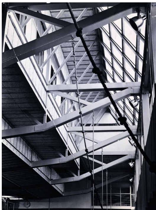
Ilustración 14. Detalle de la estructura. Fundación Alejandro de la Sota.
